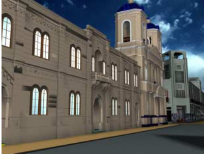
Figura 6 : Intersección calle Mendoza y Rivadavia.
